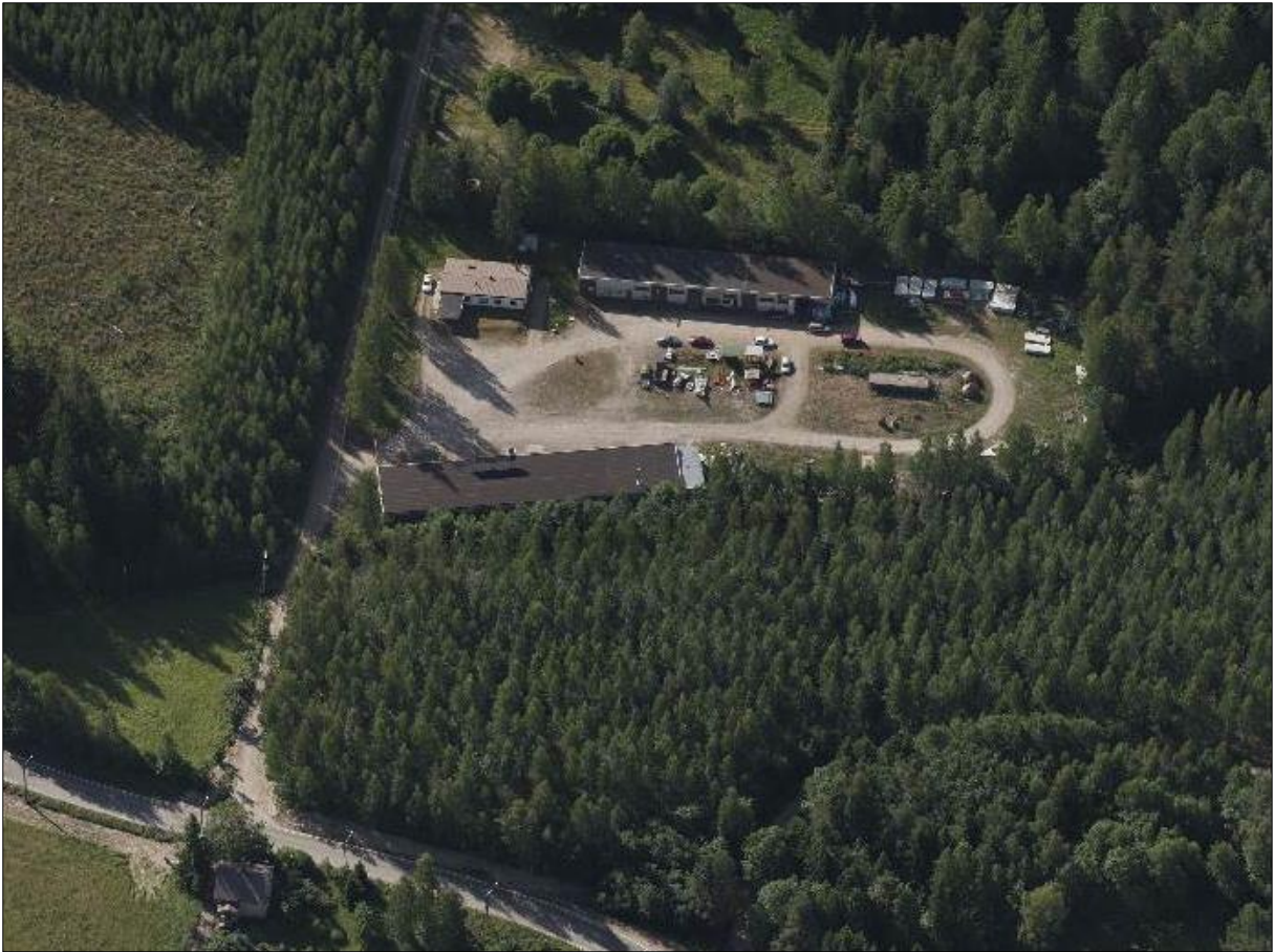
Kuva 13. Vuoden 2018 viistoilmakuva Savelantien varren entisistä metalliteollisuusyrityksen toimitilarakennuksista. ©2021 Blom.
