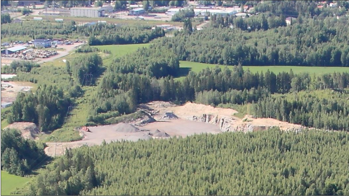
Kuva 37. Kettukallion louhimo vuoden 2020 viistoilmakuvassa.
